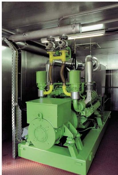
Abbildung 3-2 Motor-BHKW (Quelle: Mothermik GmbH)
