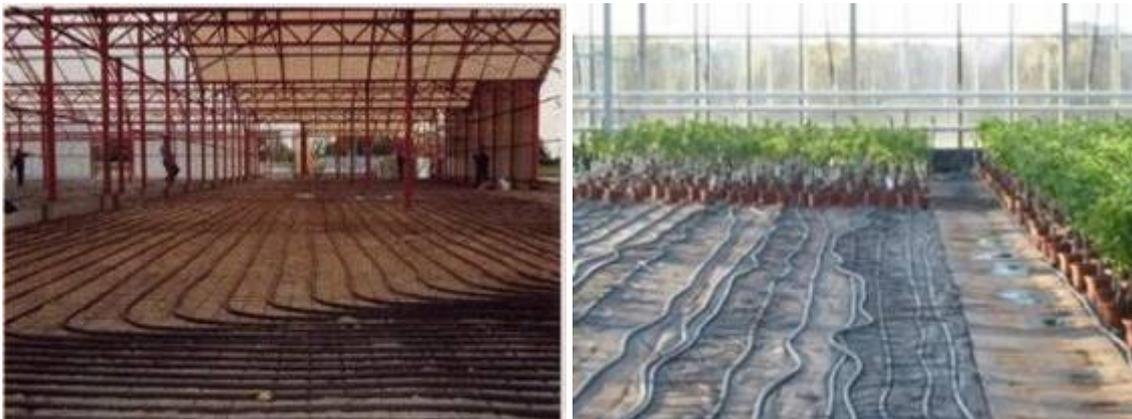
Abbildung 3-8 Bodenheizung und Vegetationsheizung (Quelle: Klaus Kuba GmbH)
