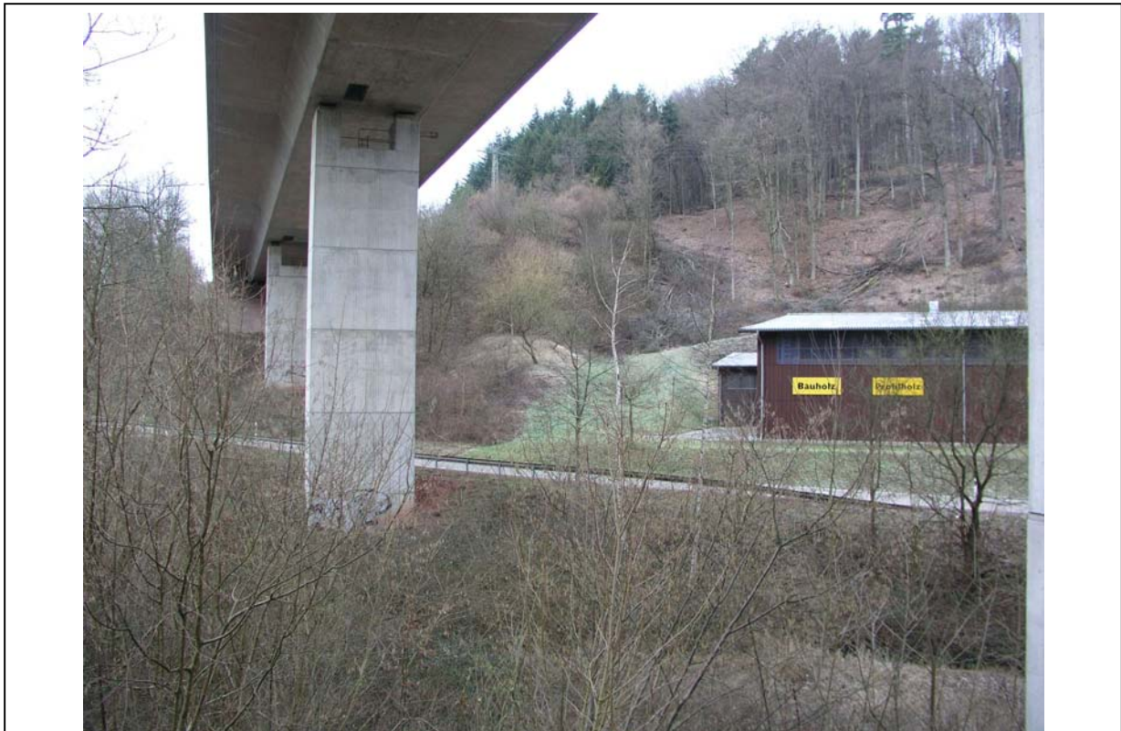
Abb. 12: Westlich der Ortschaft Wilgartswiesen überspannt die Bundesstraße 10 einen Taleinschnitt im zentralen Pfälzerwald. Durch eine wildgerechte, d. h. naturnahe Gestaltung der Umgebung ohne Habitatbrüche bzw. ohne Fremdstrukturen (Gebäude), eine effektive Hinführung (Lenkstrukturen) und eine Beruhigung (Jagdverbot, Verkehrsberuhigung etc.) könnte an dieser Stelle die Unterquerung der Trasse für Wildtiere erleichtert werden (Foto U. Hohmann 2003).
