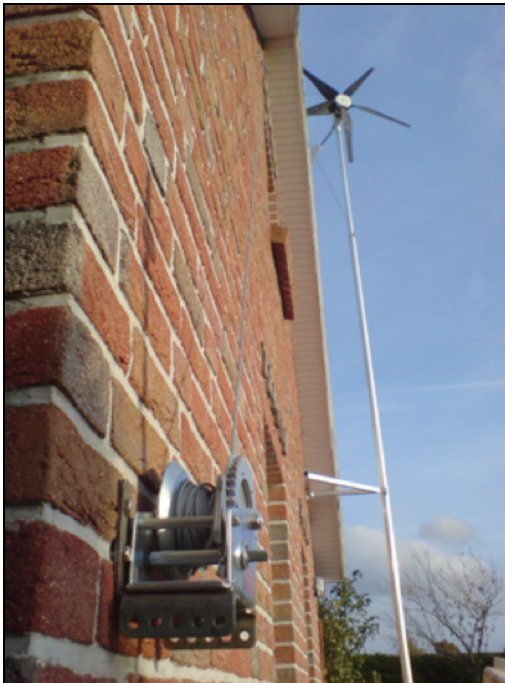
Abb. 19: An der Gebäudewand angebrachte Kleinwindkraftanlage (Quelle: Wind-SD, 2010)
