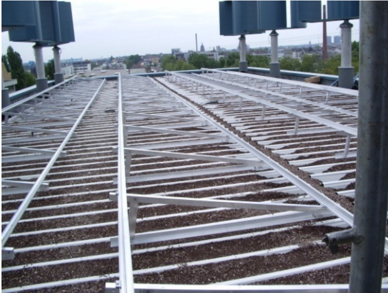
Abb. 73: Konstruktion für spätere Montage der Photovoltaikanlage (Quelle: Eigene Darstellung)
