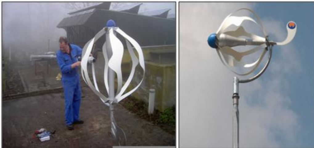
Abb. 27: Installation und fertige Ausführung der KWEA Energy Ball (Quelle: Home-Energy, 2009)
