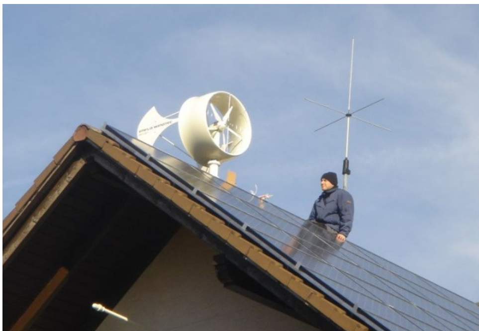
Abb. 66: Beispiel einer Dachmontage (Quelle: WinTec Systems AG)
