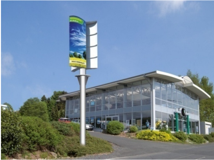
Abb. 44: Kleinwindkraftanlage als Werbeträger (Quelle: RSW Windenergy, 2010)
